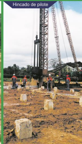
Hincado de pilote
