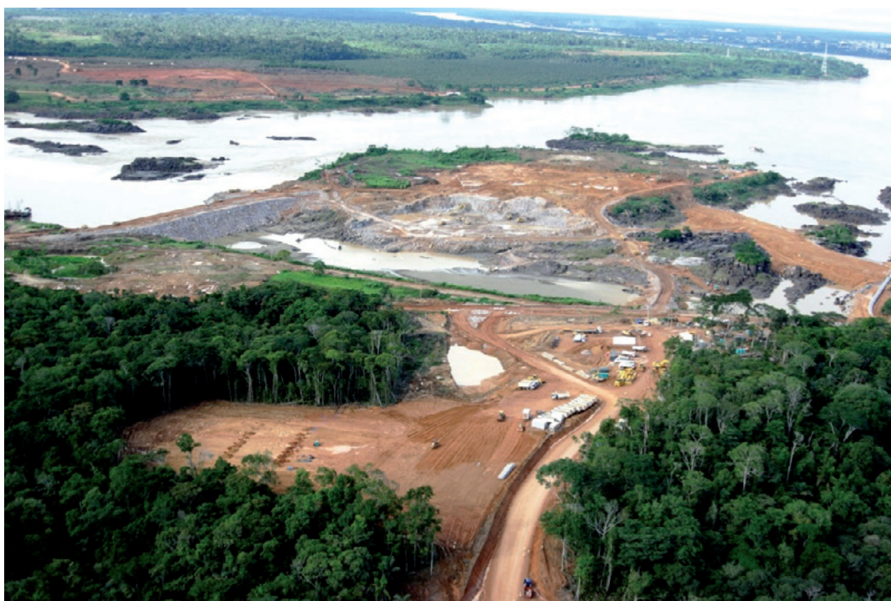
Vistas de las obras de construcción de la hidroeléctrica Santo Antônio (Fuente: BIC 2010a)
