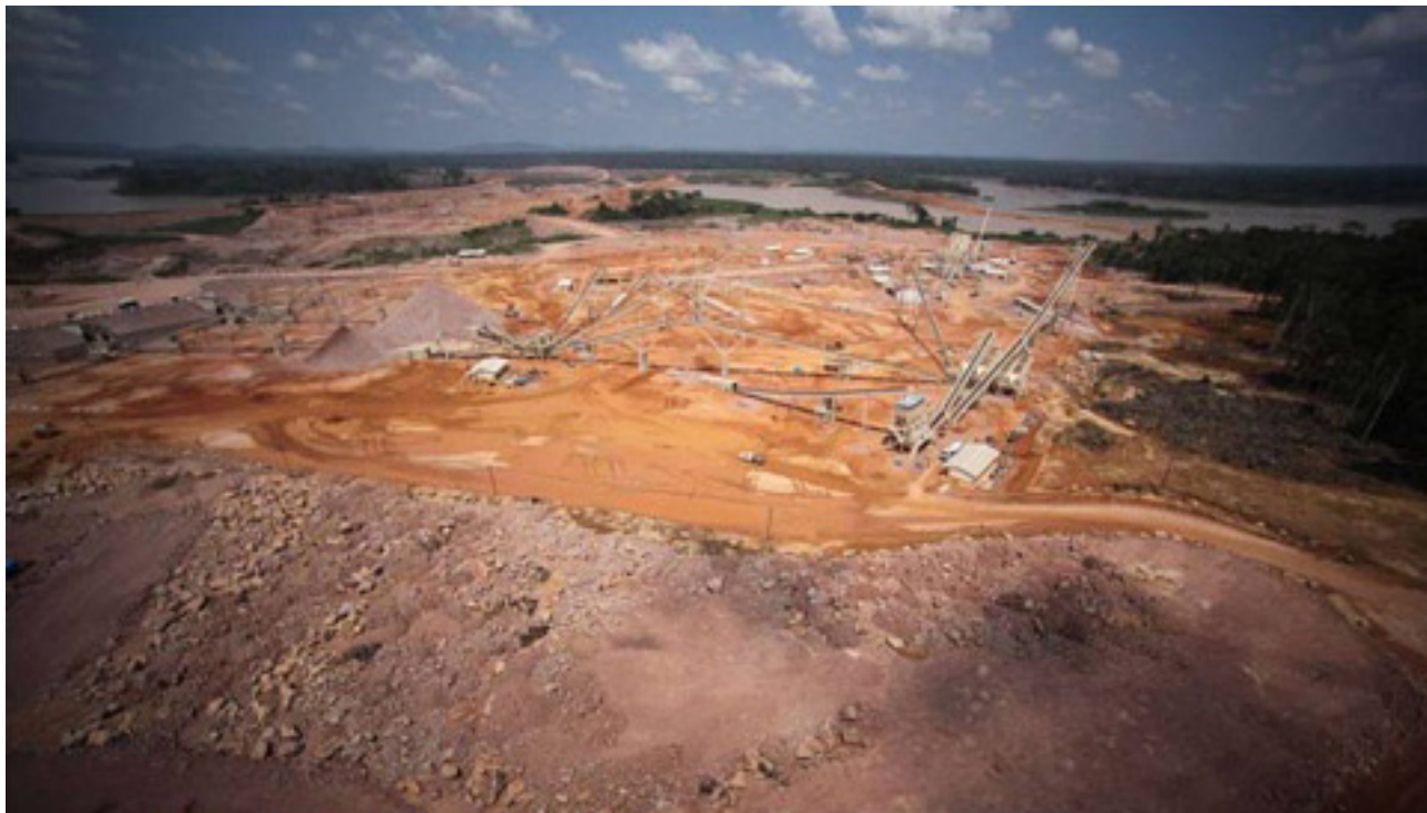
Vistas de las obras de construcción de la hidroeléctrica Jirau. Inicio del hormigonado en diciembre de 2009 (Fuente: BIC 2010b)
