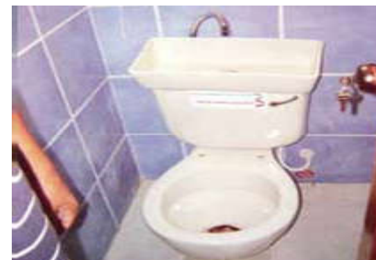
Inodoro ahorrador de agua. Contiene una palanca de doble descarga y lavamanos incorporado (usa 1 y 2 litros para orina y 6 litros para las eses fecales).
