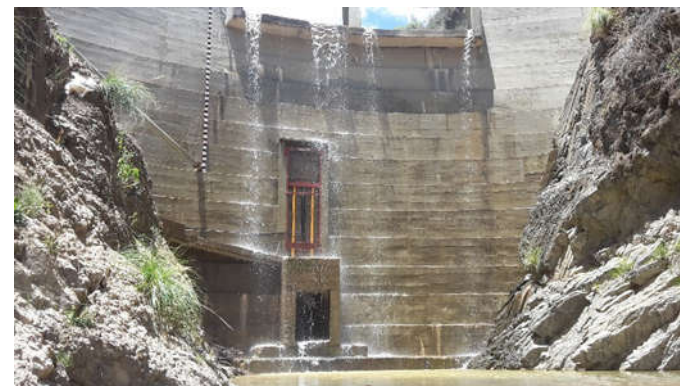
Proyecto de Riego Kainacas: Presa en Arco de H°C°. (Poroma – Chuquisaca)
