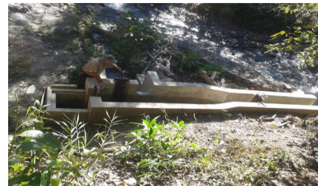
Construcción Sistema Riego Villa Barrientos obra de toma directa (CAJUATA) – MIAGUA III
